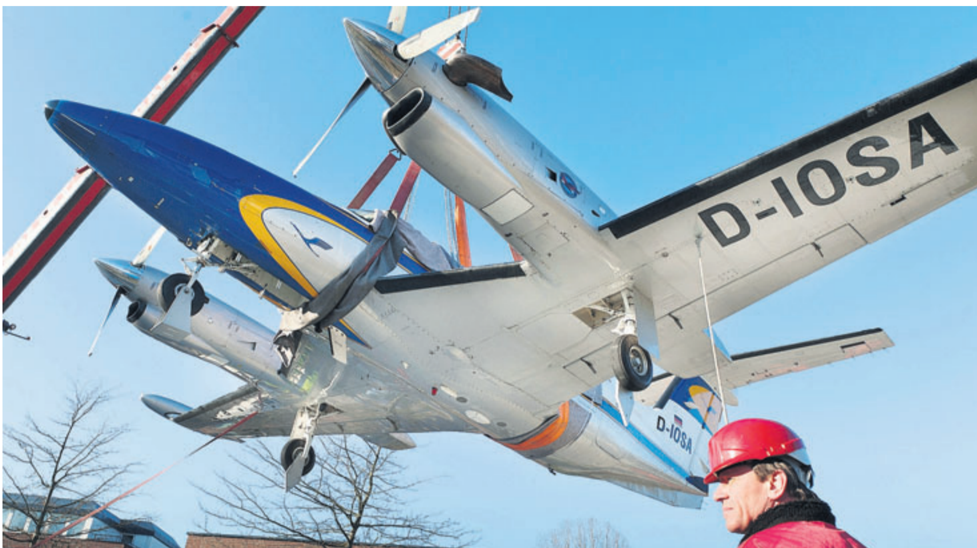
Letzter Abflug: Vorarbeiter Ewald Lenz hält das 2,5 Tonnen schwere Trainingsflugzeug in Position, bevor es auf einem Betonsockel in der Bremer Airport-Stadt fest verankert wird.
