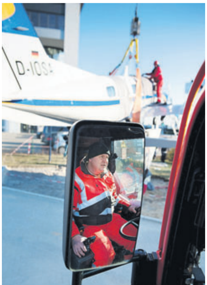
Kranführer Michael Borchers setzt das Trainingsflugzeug auf einem Betonsockel ab.
