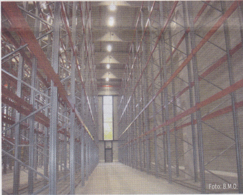
Die neue Lagerhalle in Bremen ist mit Hochregallagern ausgestattet
